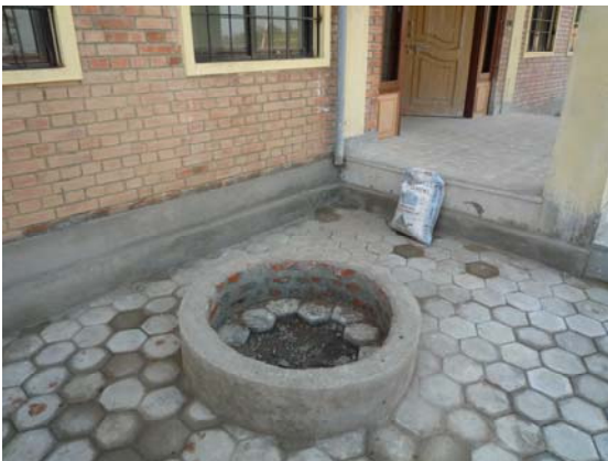
... Pflanzkübel wurden gemauert
