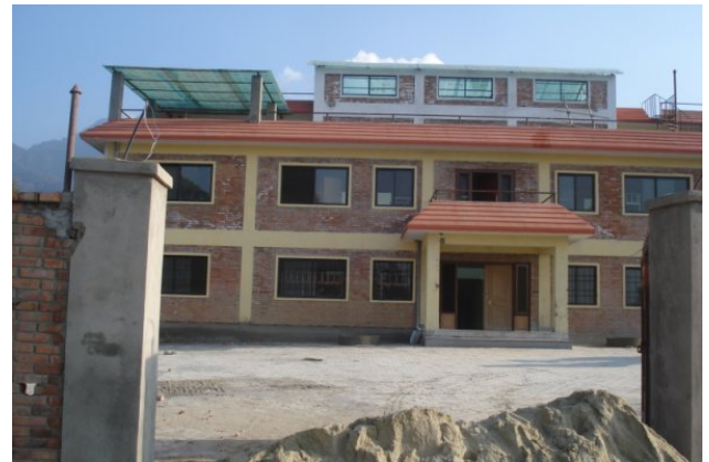
... die Pflasterarbeiten im Außenbereich sind weitgehend fertig
