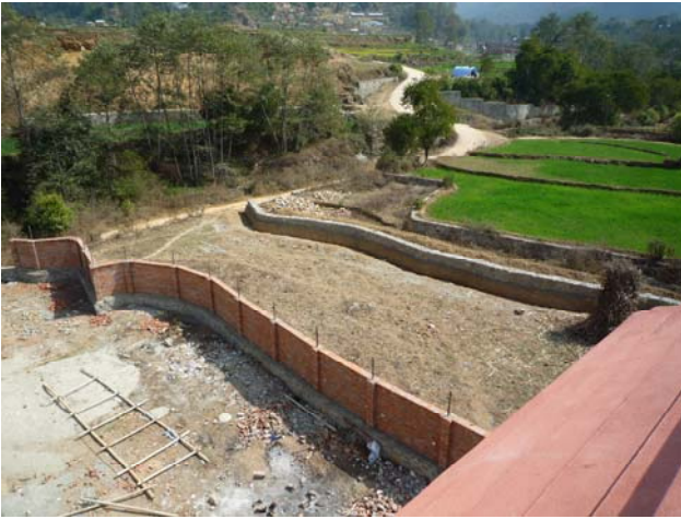
... die hintere Mauer wurde hochgezogen, es fehlt jetzt noch der Zaun
