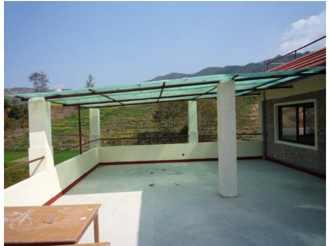
... überdachter Trockenbereich für die Wäsche
