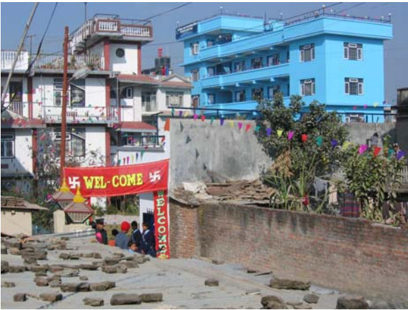
Im Hintergrund ist die fertiggestellte Schule zu sehen (blaues Gebäude)
