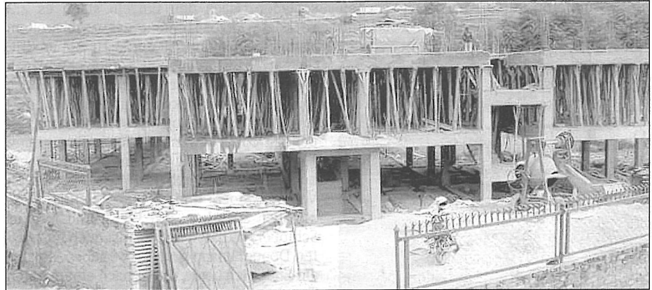
Das Kinderhaus in Godavari steht noch im Rohbau
