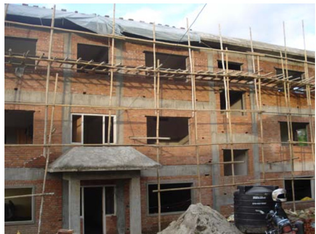
Seitenansicht, Fensterrahmen werden eingebaut
