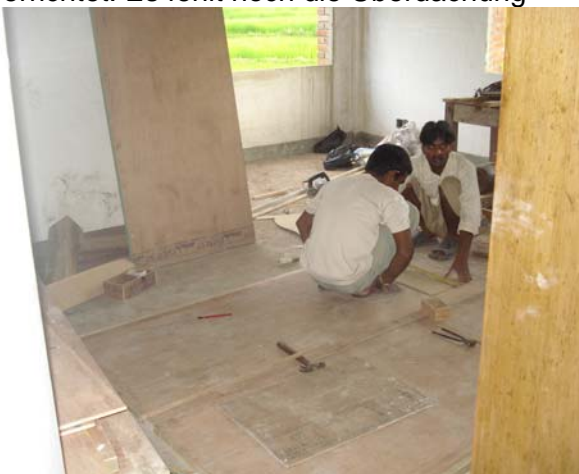
Bodenisolierung im Säuglingszimmer
