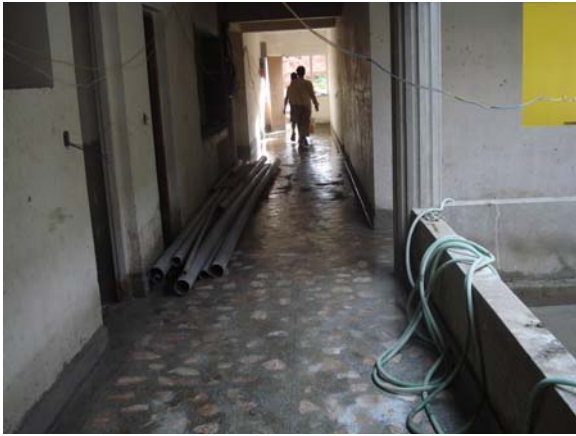
Die Flure wurden abgeschliffen
