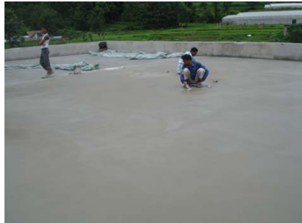
Estricharbeiten auf dem Dach
