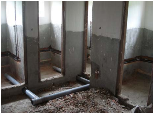
Toiletten und Duschbereich, Rohre werden verlegt
