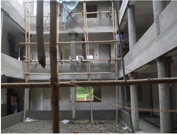
Innenansicht vom Atrium
