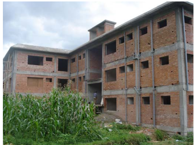
Gartenansicht, die Außenrohre sind gelegt
