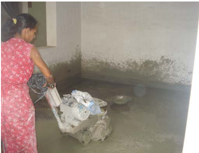
die Böden werden abgeschliffen
