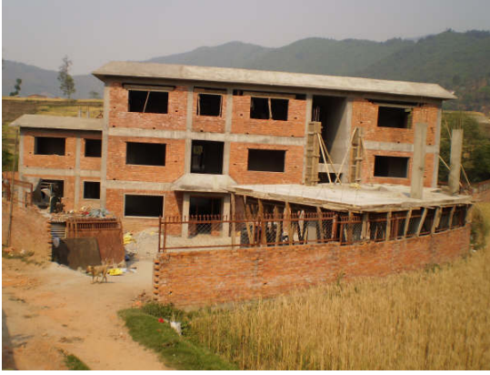
Bautenstand April 2009 Ostansicht
