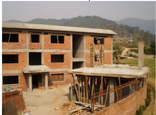
Bautenstand April 2009 Seitenansicht
