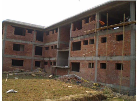
Bautenstand April 2009 Gartenansicht
