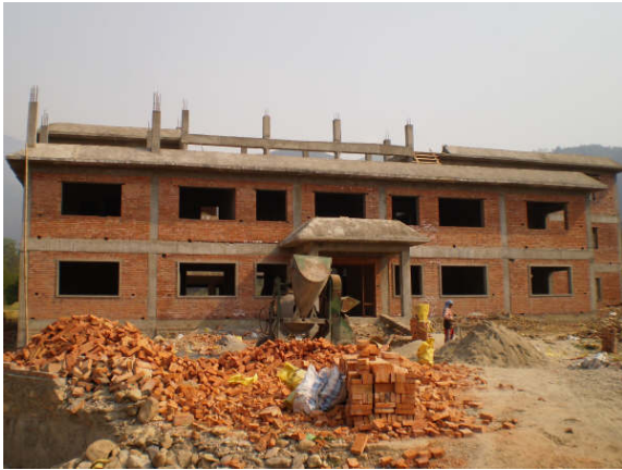
Bautenstand April 2009 Haupteingang
