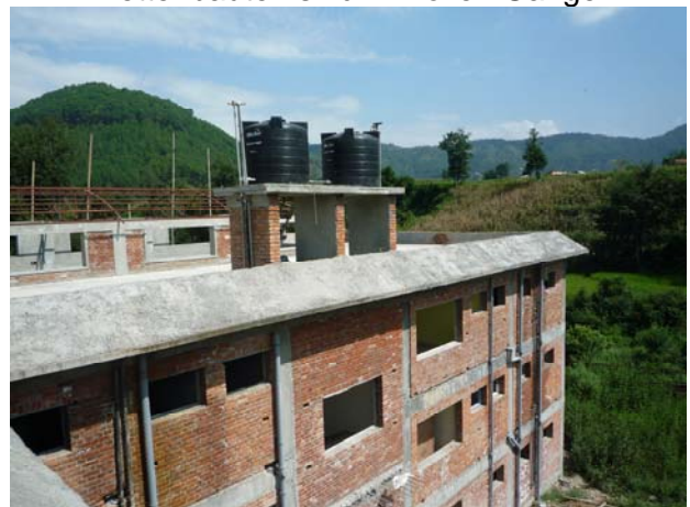
Wassertanks auf dem Dach wurden installiert
