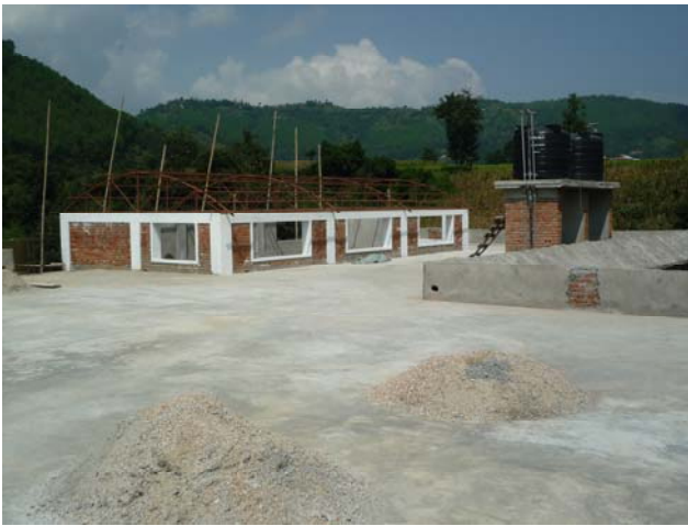
auf dem Dach
