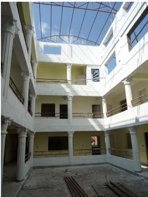
die Geländer werden befestigt
