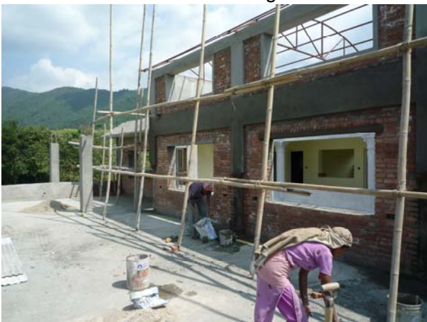
die Außenfassade wird verputzt
