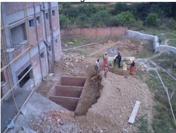
Die Sickergrube wird gemauert
