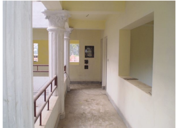
Geländer in den Fluren wurden angebracht
