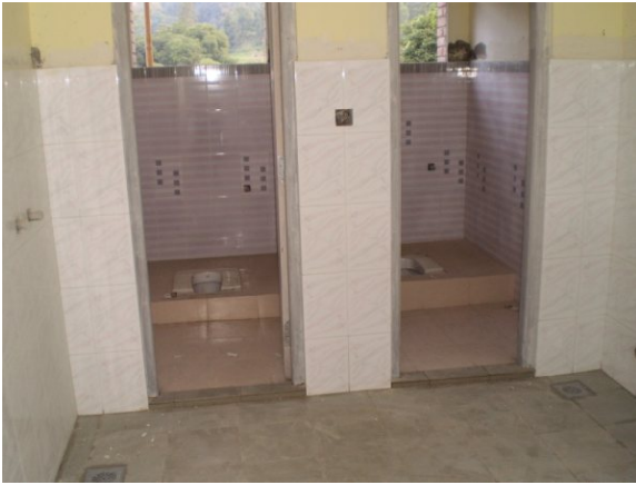
Teilweise Steh-toiletten für die Kinder
