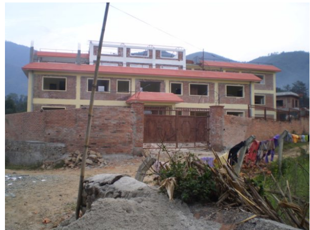
Haupteingang mit dem eingebauten Hoftor
