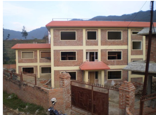
Teilansicht vom Seiteneingang mit Tor
