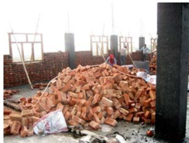
... Bilder der Bauphase für die nächsten 7 Klassenzimmer
