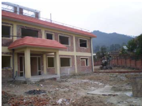
Teilansicht vom Haupteingang - man hat angefangen den Vorplatz zu ebnen. Eine sehr aufwendige Arbeit, da es hierfür keine Maschinen gibt.
