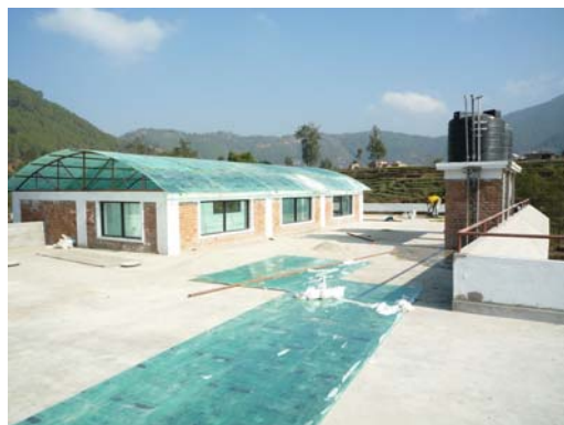
... Dach über dem Innenhof
