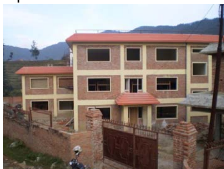
Teilansicht vom Seiteneingang mit Tor
