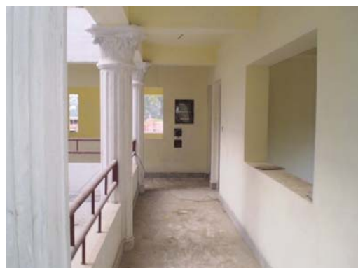
Geländer in den Fluren wurden angebracht
